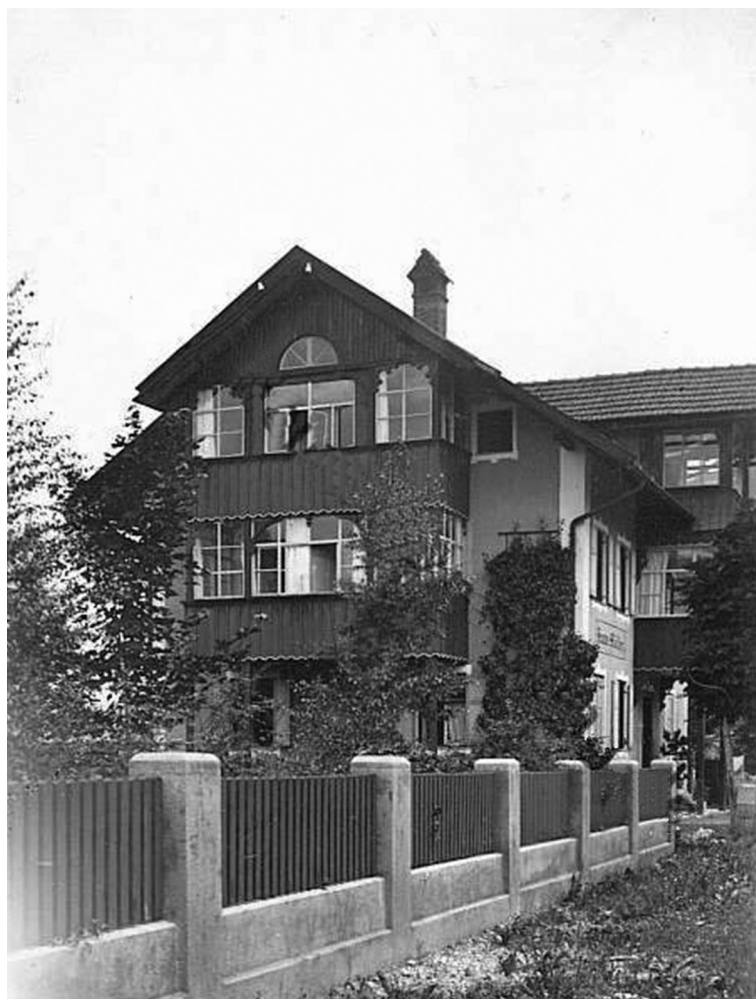
Das Wohnhaus in Oberstdorf
